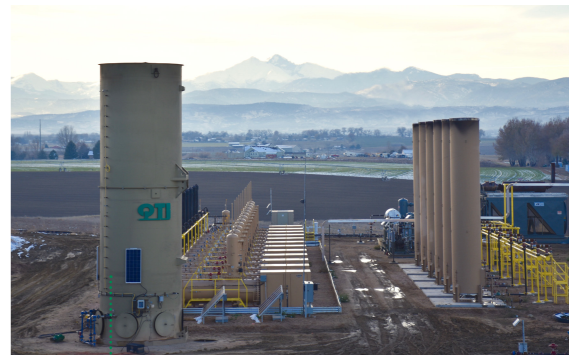
PRODUKTIONSANLAGEN AUF DEM MARKHAM-BOHRPLATZ
